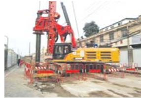
施工作业区用护栏隔开
