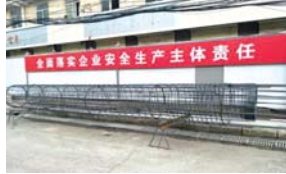
滚焊机做出的钢筋笼顺利通过首件验收 成品质量得到业主的认可
