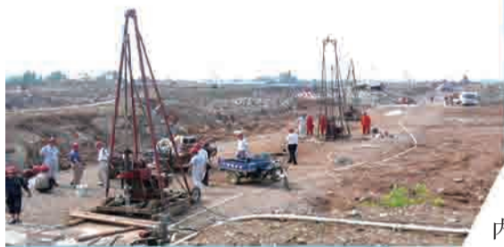
▲ 2009年6月，徐州高铁站施工现场
