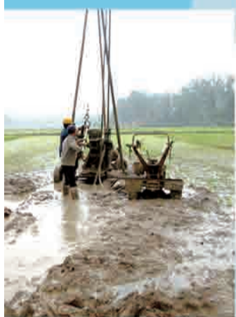
▲ 2014年8月，大连栉状铁路施工现场
