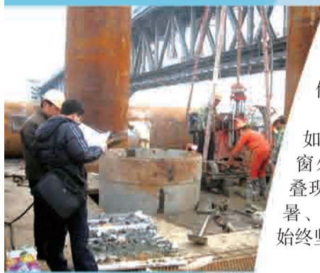
▲ 2010年3月，上海金山铁路黄浦江上施工现场
