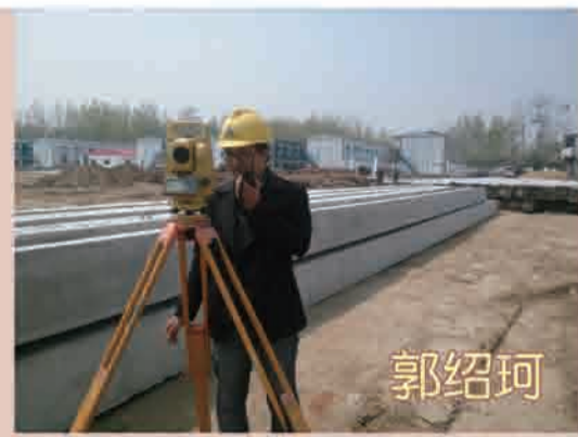
基础篇 左图：郭绍珂，2015年邳州市安和苑预制桩工地用全站仪对现场桩位进行测放工作。 右图：王瑞军，曹妃甸振冲碎石桩桩头开挖。
